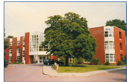
Moderne und großzügige Praxis- und Dialyseräume im Zentrum
